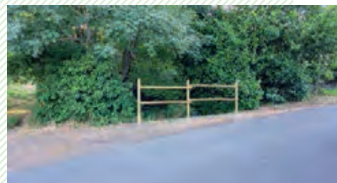
Sécurisation rue des caves rase du marais
