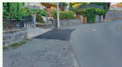
Chantier rue du Sucquet la rase du marais
